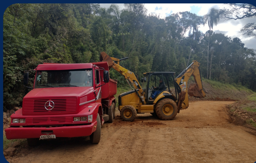
DRENAGEM SUPERFICIAL PCH BOA VISTA II - Turvo/PR
