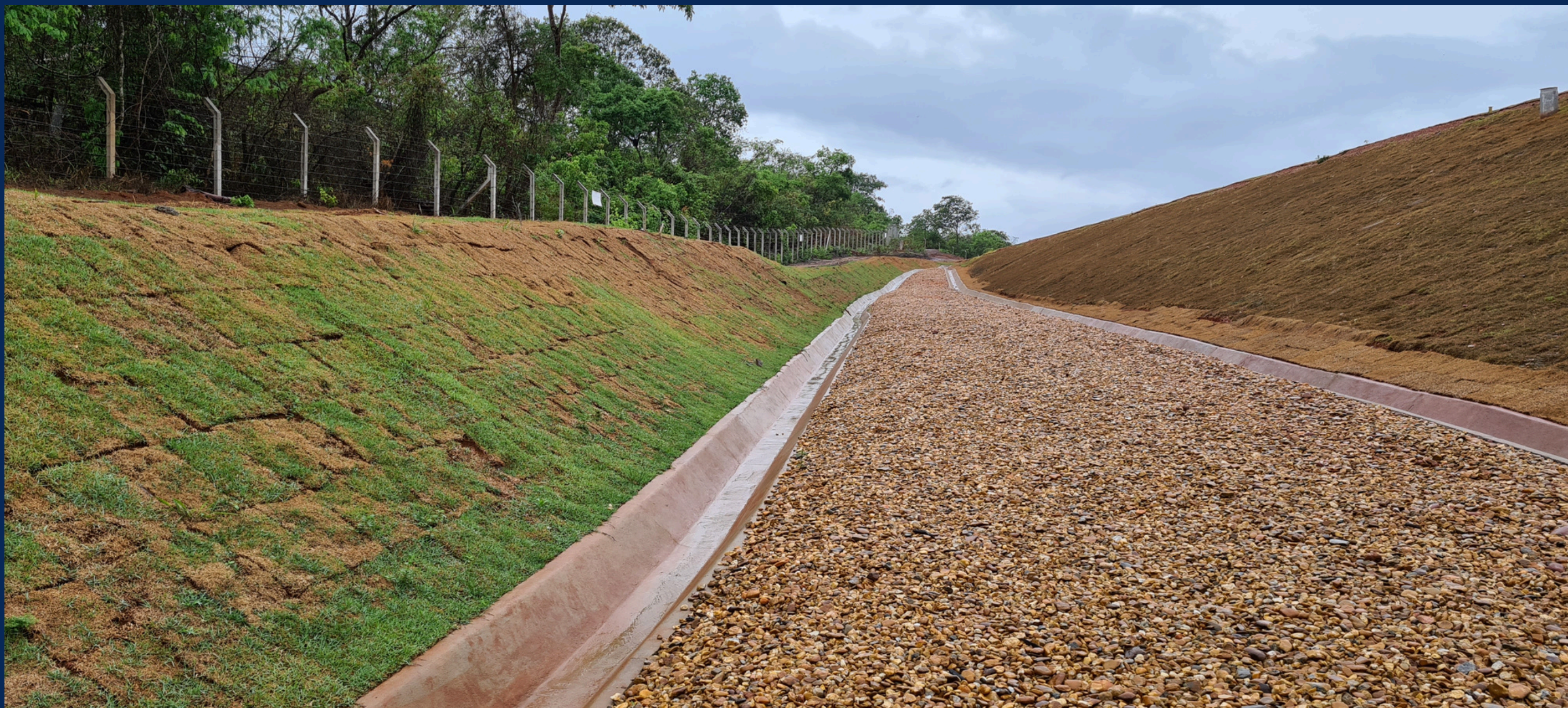
DRENAGEM SUPERFICIAL PCH TAMBORIL - Cristalina/GO
